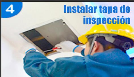
Atornillar marco del registro a los refuerzos previamente instalados utilizar 2 tornillos 8x1 cabeza plana o lenteja en cada refuerzo, fijarse en las zonas para atornillar que cuenta el marco
