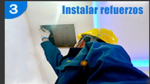
Instalar refuerzos con perfiles de acero galvanizado o madera al borde del rasgo realizado. Al menos 2 refuerzos en paralelo. El largo del refuerzo según largo o lado de medida comercial
